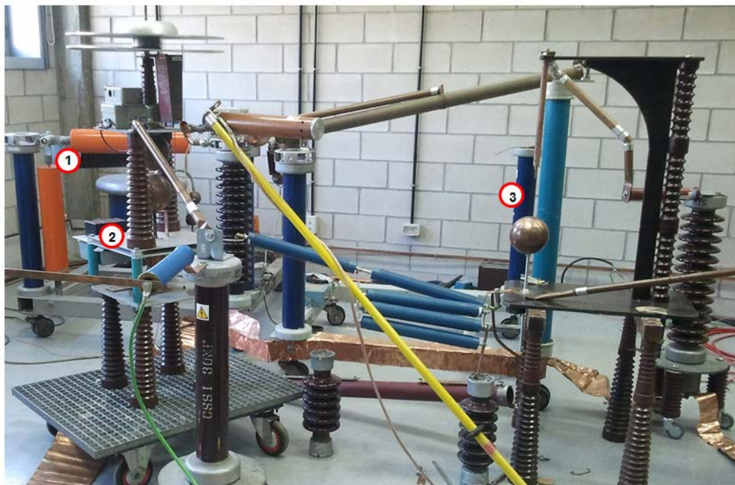
Fotografía 4-1 – Montaje de ensayo experimental para la configuración punta-esfera, correspondiente a la Instalación 2G.
