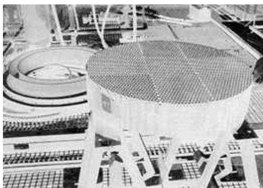
Fig. 2-31. Vista frontal del receptor Conphoebus – Naples. Detalle de las 9 secciones (fuente: [110])
