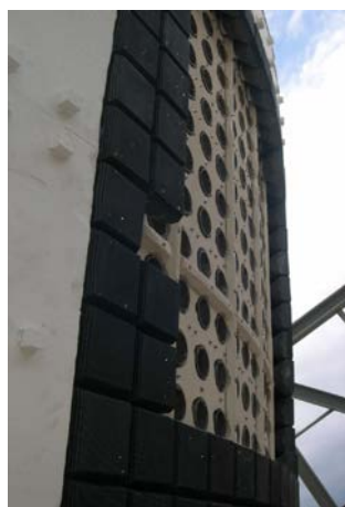
Fig. 2-44. Montaje de las copas del receptor SOLAIR 3000 (fuente: psa.es)
