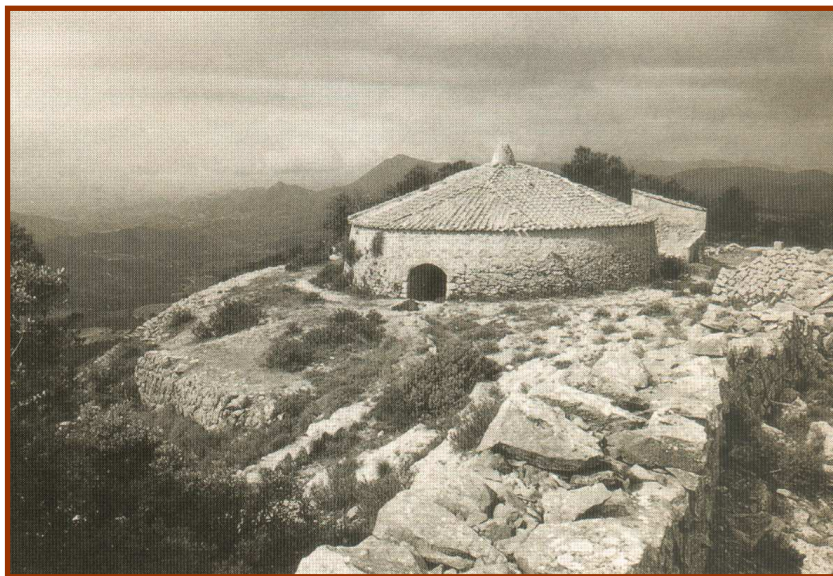
Figura 344: El pozo de nieve, de característica forma circular, llegó a ser una construcción bastante familiar en las zonas frías y montañosas de nuestro país
