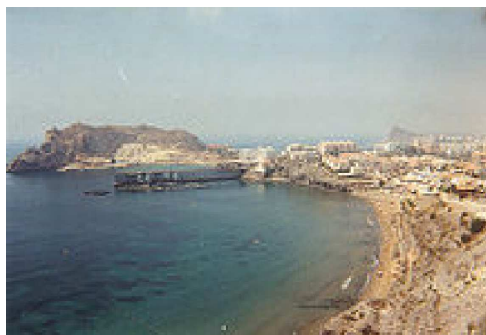
Antiguo embarcadero ferroviario para el mineral
