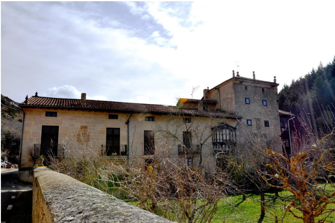
Ilustración 83: Palacio de los Arce-Bustillo. Fachada principal [autor: Santiago Abella]
