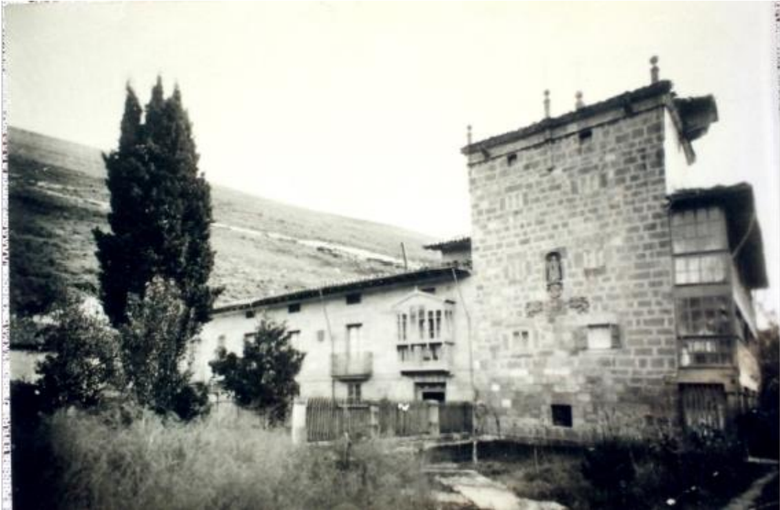
Ilustración 80: fotografía antigua de la Casa Torre de los Arce-Bustillo [Archivo Privado Familiar del Linaje Bustillo-Gallo]
