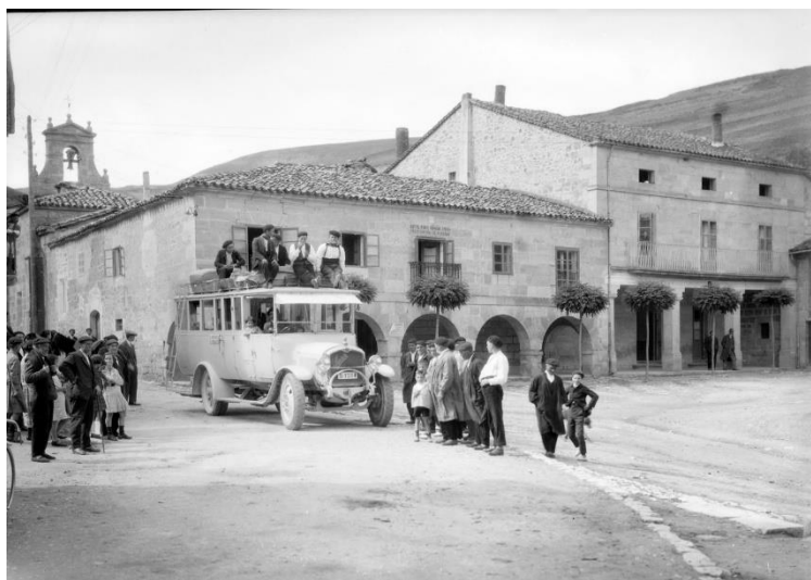
Ilustración 64: fotografía antigua de la casa de Manuel Gallo Cuadrao, antes de la reforma del ayuntamiento (Plaza de Sedano) [Archivo Municipal de Burgos, Foto Vadillo, FO -1519]
