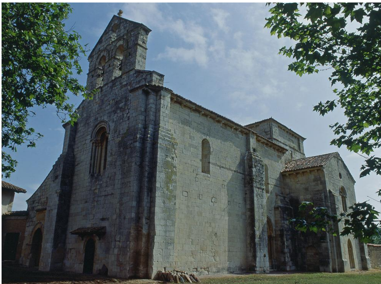
Lámina 1: Vista general de la iglesia de Santa Eufemia de Cozuelos, desde su fachada principal, en el año 2007 (Jesús Herrero Marco) 9
