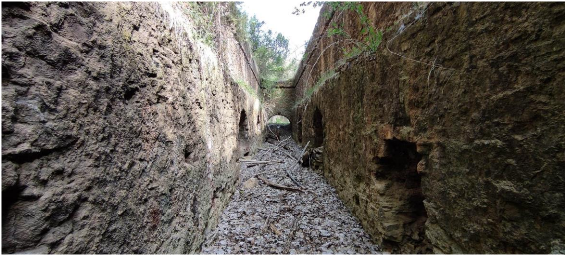
Figura 25. Interior de la ferrería de Torete. Fuente: Elaboración propia.
