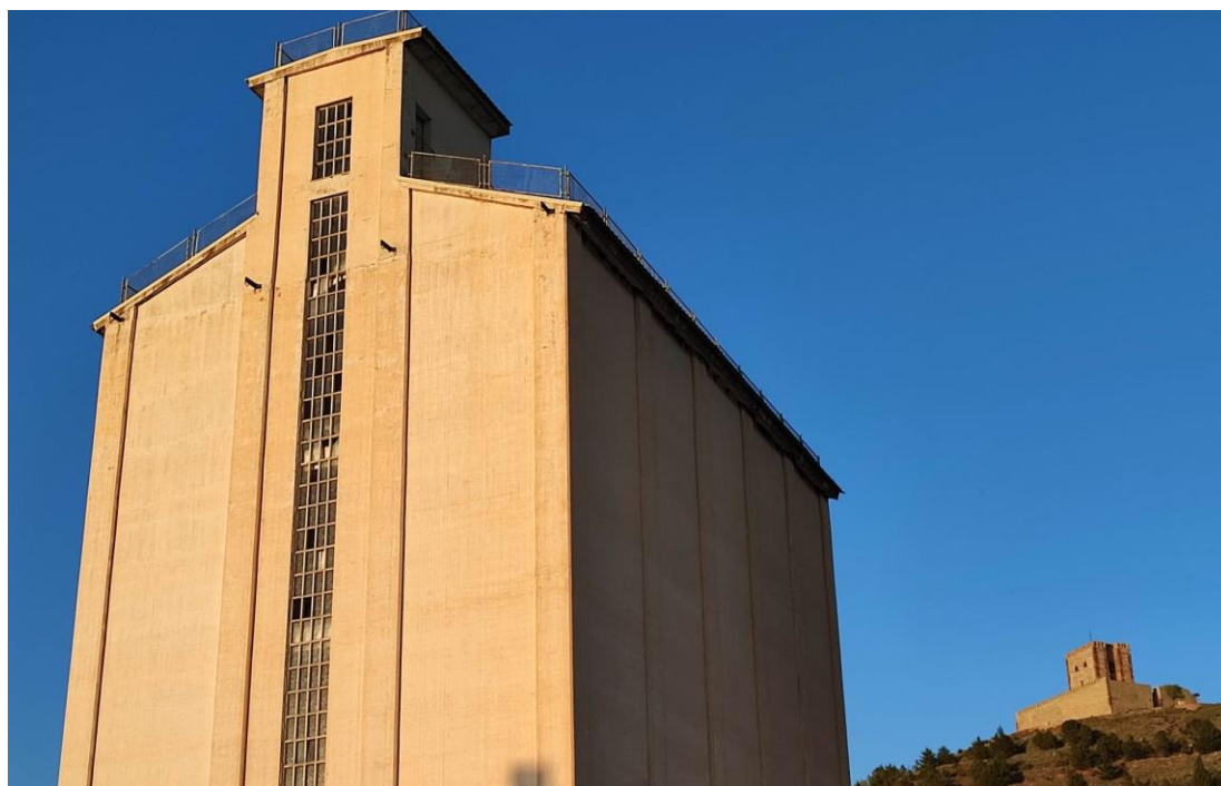
Figura 4. Silo de Molina de Aragón. Fuente: Elaboración propia.
