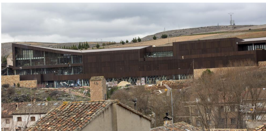
Figura 44. Parador Nacional de Turismo de Molina de Aragón (en construcción). Fuente: Elaboración propia.
