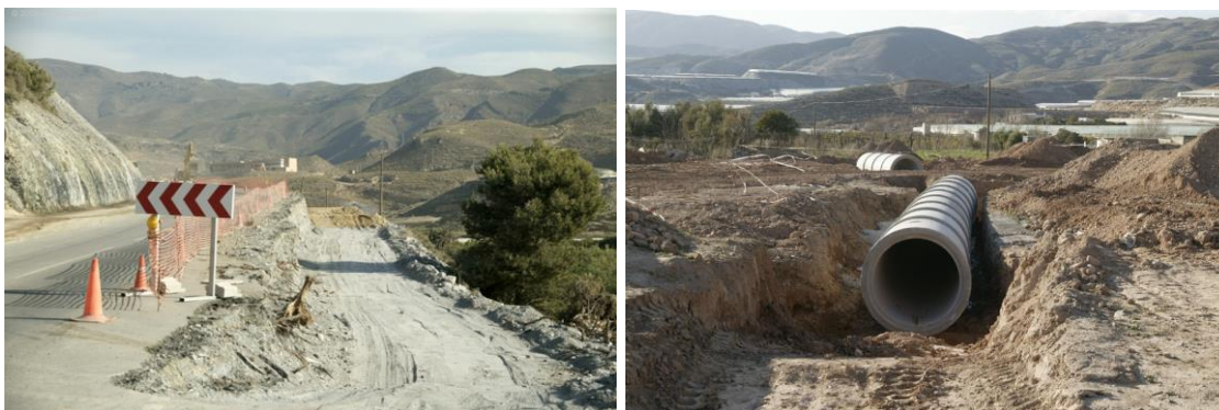
Figura 30. Ejemplo de relación de los niveles. Ambas imágenes tienen la clase de movimiento de tierra como nexo de unión. En la primera existe una dependencia en donde la clase desvío de tráfico es necesaria para que se establezca la de movimientos de tierra. En la segunda es, al contrario, ya que es necesario que el movimiento de tierras se establezca para que exista el drenaje.
