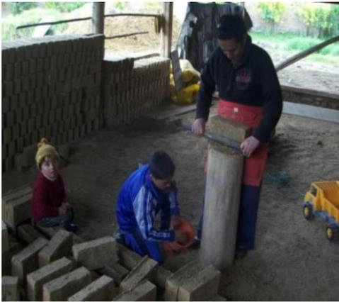
Figura 4. Raspado de ladrillo. Fuente: [5]
