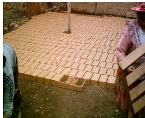
Figura 3. Moldeo de ladrillos. Fuente: [6]
