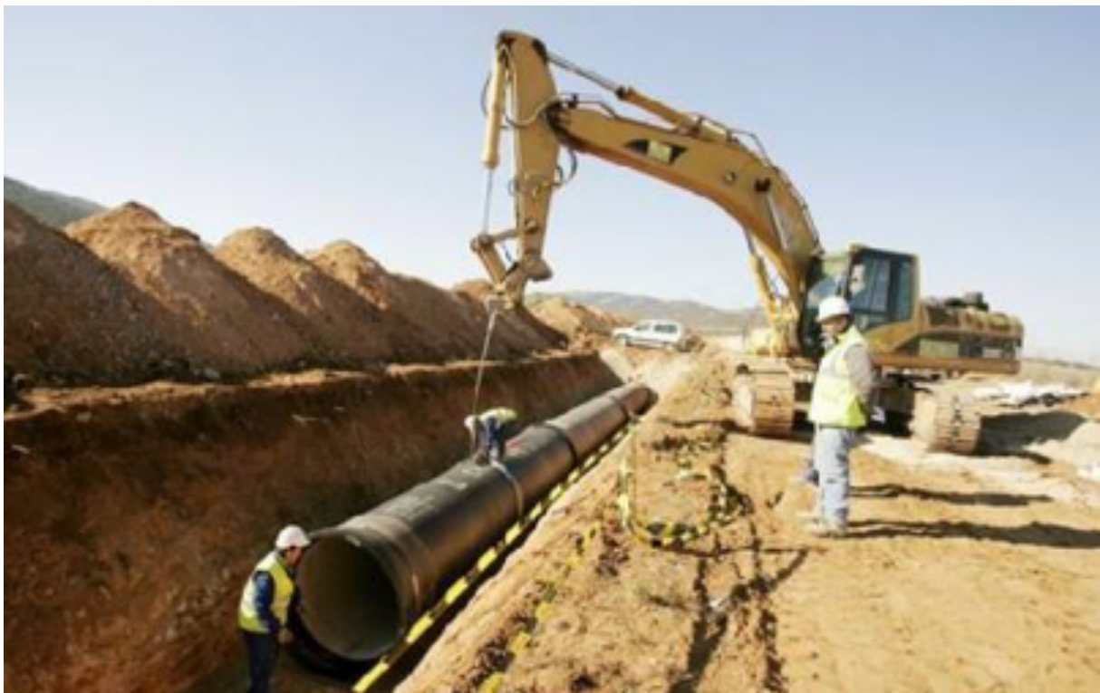
Tubería manchega, instalación y trazado. Fuente: www.guadalajaradiario.es y Plan Especial del Alto Guadiana
