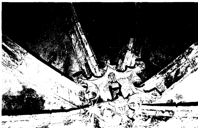
Fig. 2. Estado inicial. Repintes en la Clave.
