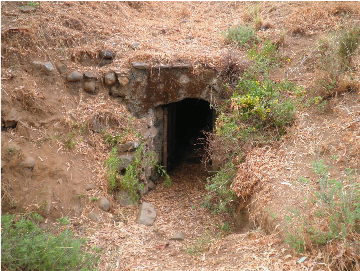
FIGURA 8. DETALLE DE LA MINA DE DRENAJE SITUADA BAJO EL DESPOBLADO. Fuente: autor.
