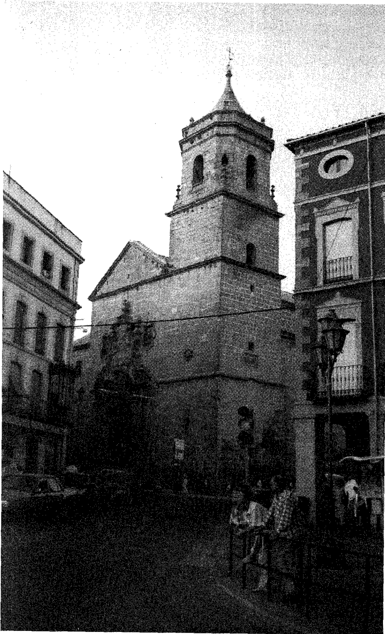
Fig. 4. Exterior de la iglesia. Portada de Poniente y campanario.
