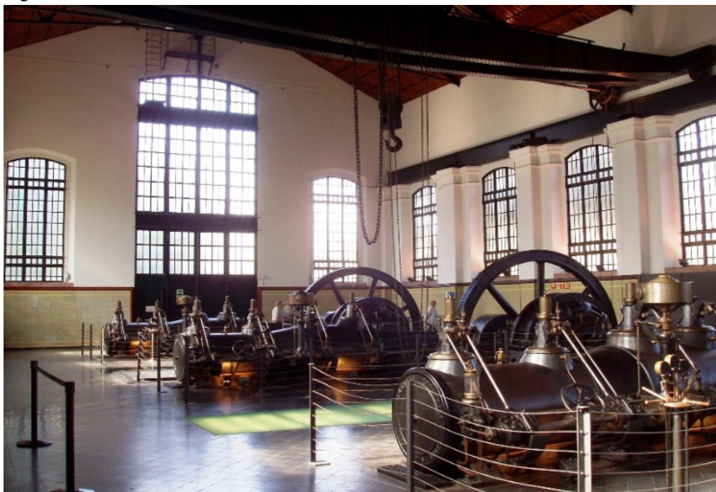
Figura 5. Sala de electricidad del Museo AGBAR.
