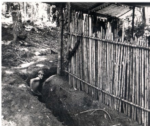
Figura 1: Fabricación de trincheras en las escuelas durante la ofensiva en 1987. Foto donada por Tomás, guerrillero del EGP (2001)
