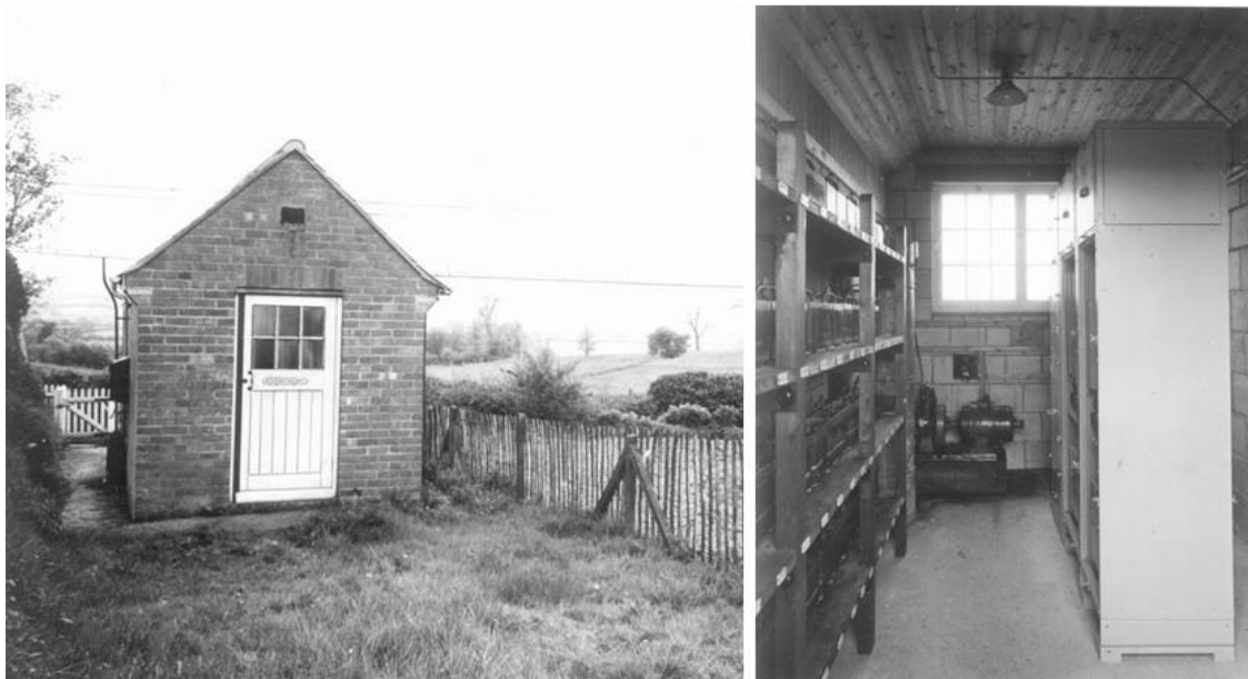
Figura 2: Vistas exterior e interior de una central rural UAX12 en Brockton (Reino Unido). Fuente: The UAX Project http://www.uax.me.uk
