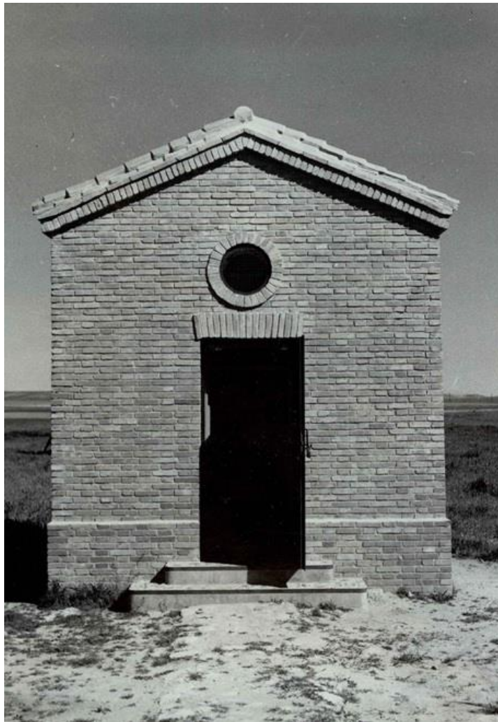
Figura 4: Caseta de equipo repetidor de la línea coaxial Madrid-Barcelona. Archivo Histórico Fotográfico de la Fundación Telefónica.
