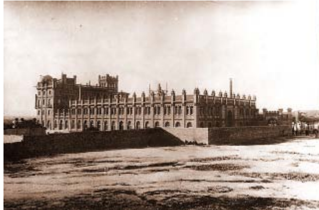
La nueva fábrica durante su construcción en 1915.
