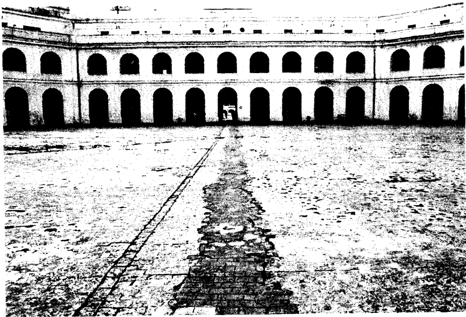
Patio del Cuartel de Batallones de la Nueva. Población de San Carlos.
